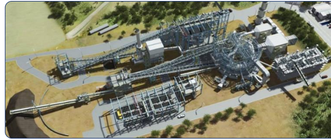
Heißgaserzeugung zur Herstellung von Eisenerzpellets
